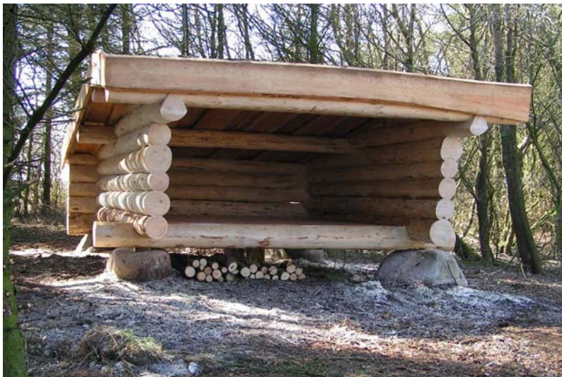
Shelter in het bos
